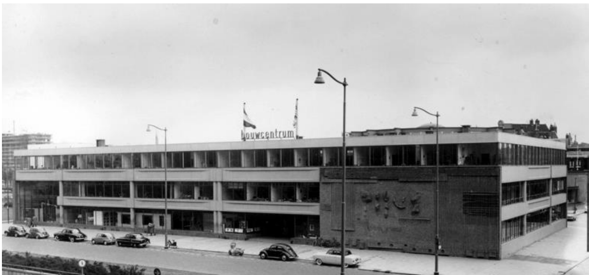
Afbeelding 37: Rotterdam, Eerste uitbreiding van het Bouwcentrum , de voorgevel met hoofdingang en kunstwerk van Moore, 1953-1956, Joost Boks (foto: Stadsarchief Rotterdam, toegangsnummer 4100, Fotocollectie algemeen - deel 1, inv.nr. 2004-5577, ca. 1956.).
