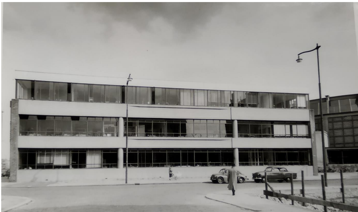
Afbeelding 53: Rotterdam, Eerste uitbreiding van het Bouwcentrum , de westgevel met de duidelijk in het zicht gelaten constructie, 1953-1956, Joost Boks (foto: Het Nieuwe Instituut, Rotterdam, Boks , J.W.C. (Joost Willemsen Cornelis) / Archief (BOKS 0006), inv.nr. ph362, niet gedateerd, ca. 1956.).
