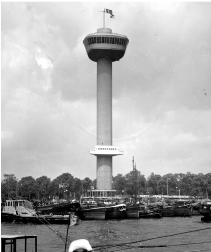
Afbeelding 94: Rotterdam, Euromast , 1958-1960, Huig Maaskant (foto: Stadsarchief Rotterdam, toegangsnummer 4117, Collectie F.H. van Dijk, inv.nr. 1976-8762, ca. 1960.).
