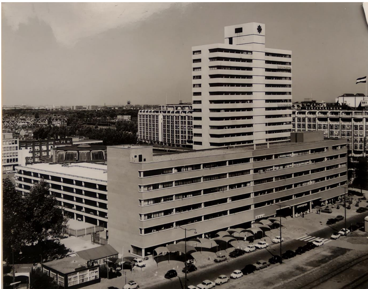
Afbeelding 77: Rotterdam, Het Bouwcentrumcomplex , de voorgevel van de Kruispleinvleugel, 1946-1970, Bureau Boks Eijkelenboom Middelhoek (foto: Stadsarchief Rotterdam, toegangsnummer T45-01, Van der Mandele, inv.nr. 560, ca. 1970.).
