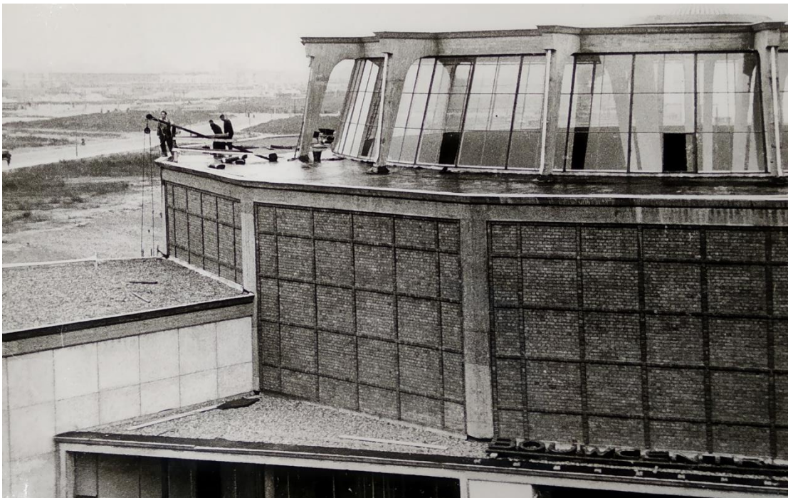
Afbeelding 28: Rotterdam, Het Bouwcentrum , deel van de voorgevel met zicht op het siermetselwerk en de glazen kroon, 1946-1949, Joost Boks (foto: Het Nieuwe Instituut, Rotterdam, Boks, J.W.C. (Joost Willemsen Cornelis) / Archief (BOKS 0004), inv.nr. ph51, niet gedateerd.).
